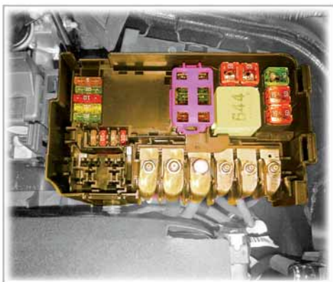
Sicherungsträger im Motorraum
