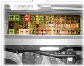
Sicherungshalter, unterhalb der Lenksäule
